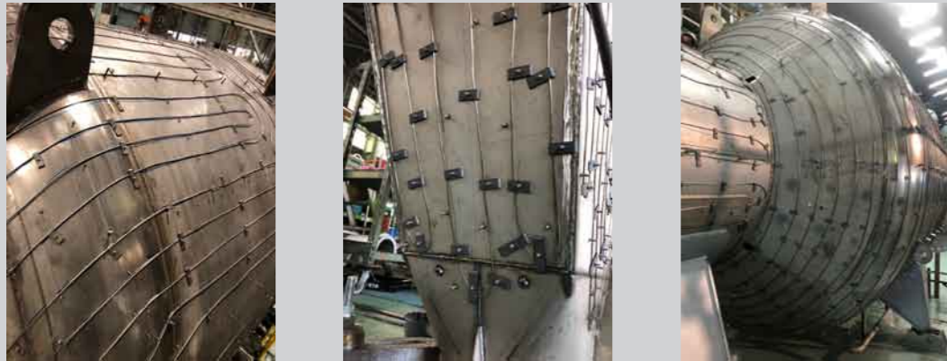
ヒーター施工
