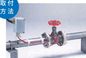
保温カバー取付前
