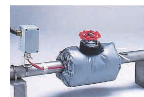
保温カバー取付後
